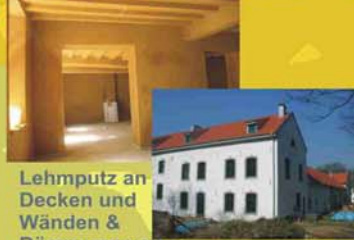
1a) Saniertes Bruchsteinhaus
